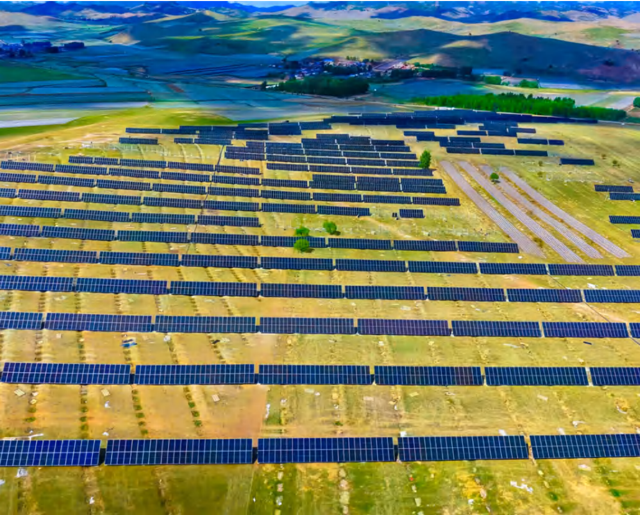
科右前旗光伏帮扶项目
