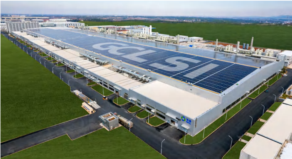
芜湖协鑫光伏电站
